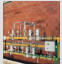
Gasdruck- Regelstrecke
