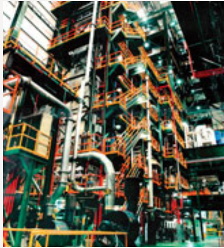
Bandverzinkungsanlage Werksfoto Fa. Electric-Furnace
